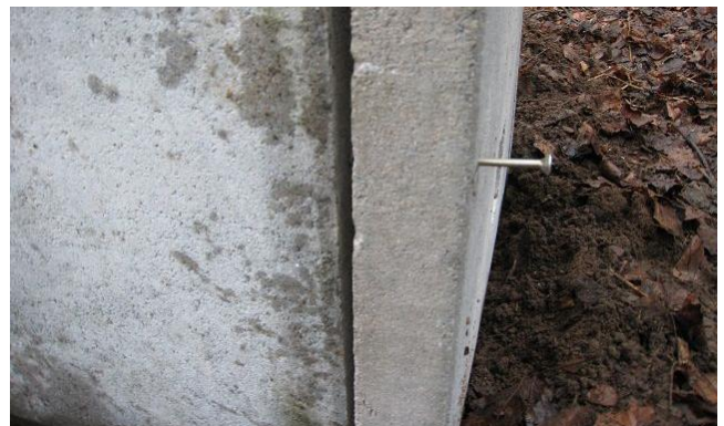
Eine Schraube hält zwei Platten zusammen.
